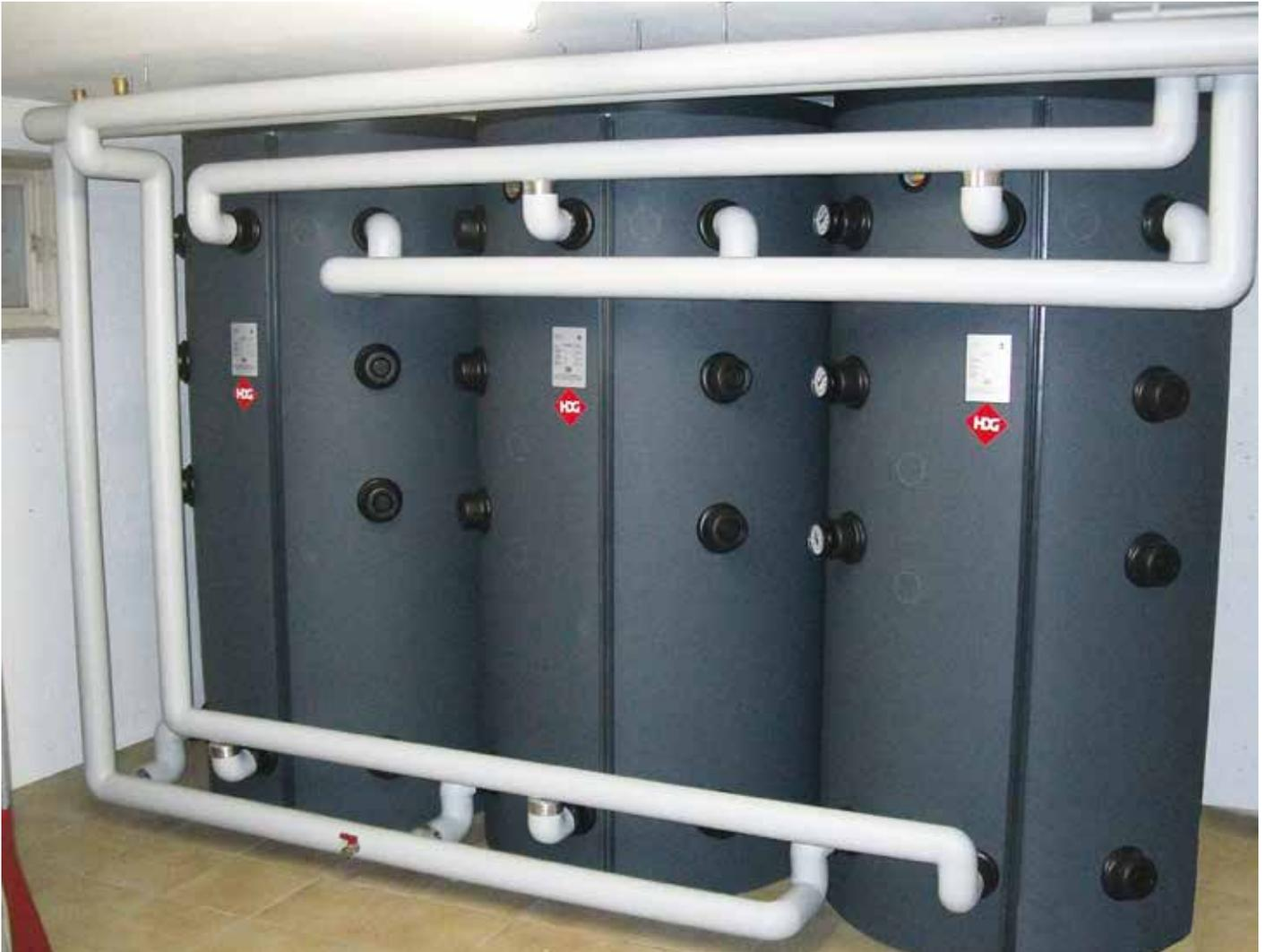
Ein Pufferspeicher stellt die zentrale Wärmeversorgung einer Heizanlage dar. Er nimmt Energie aus dem Heizkessel auf und gibt sie bedarfsgerecht an das Heizsystem wieder ab. Die HDG Pufferspeicher gleichen Minder- und Spitzenleistungen aus, verringern die Kesselauf-
